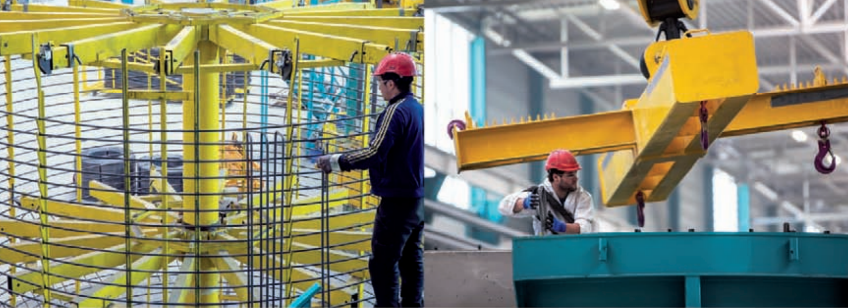
EISENBINDER BEI DER BEWEHRUNG | KRAN FÜR BIS ZU 50 TONNEN SCHWERE ELEMENTE
