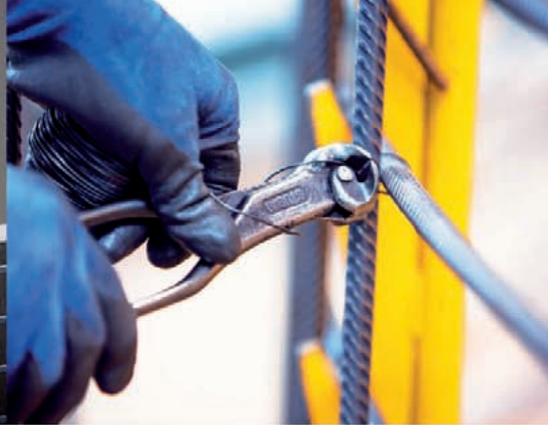
LAGERUNG DER TURMSEGMENTE | DETAILANSICHT EISENBINDEN
